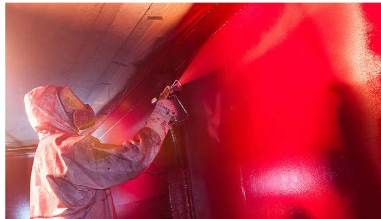
Unter der Schutzhülle wird Korrosionsschutzfarbe aufgetragen.
