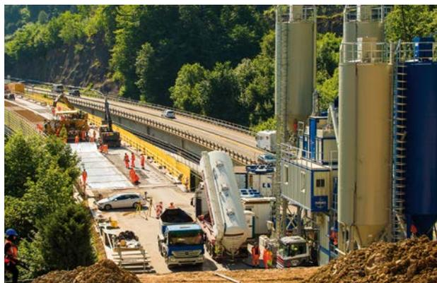
Instandsetzung nach rund 45 Jahren: Sanierung der drei Brücken Boli, Mettlen und Linden bei Küssnacht (Kanton Schwyz)
